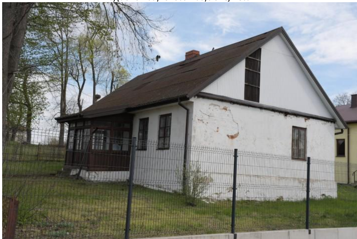
Zdjęcie 10 Budynek obok zabytkowej Plebani
