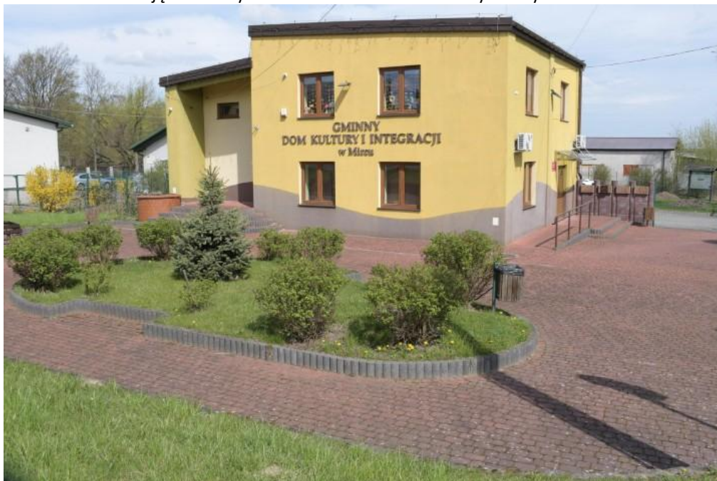
Zdjęcie 2 Budynek Biblioteki i Ośrodka Kultury Gminy Mirzec
