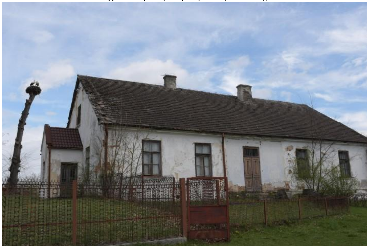
Zdjęcie 7 Zabytkowy budynek plebani (stan obecny)
